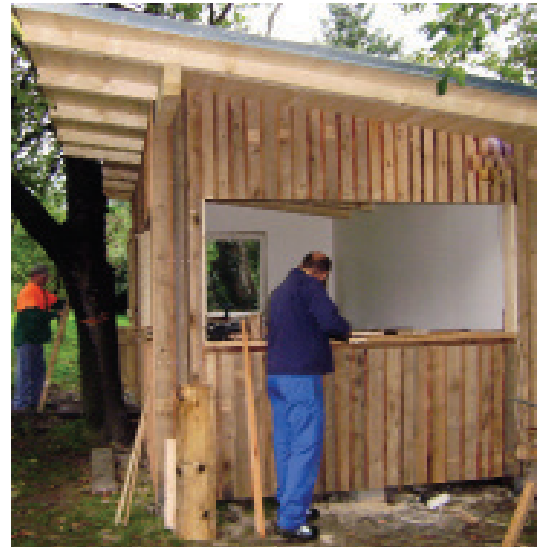
Abschlussarbeiten an der neuen Sterzhütte (Foto: P. Simon)
